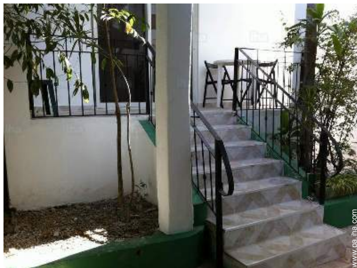
vista desde la terraza cubierta
